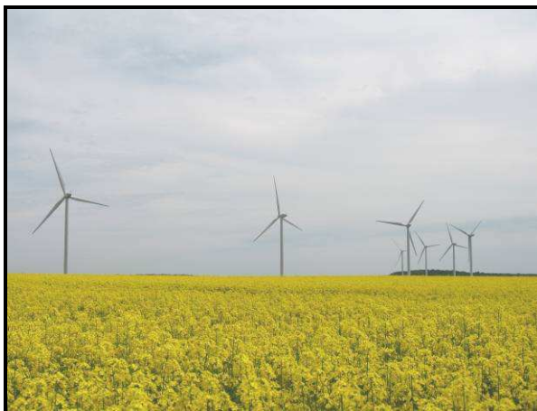
Vue partielle du parc éolien du Chemin des Haguenets
