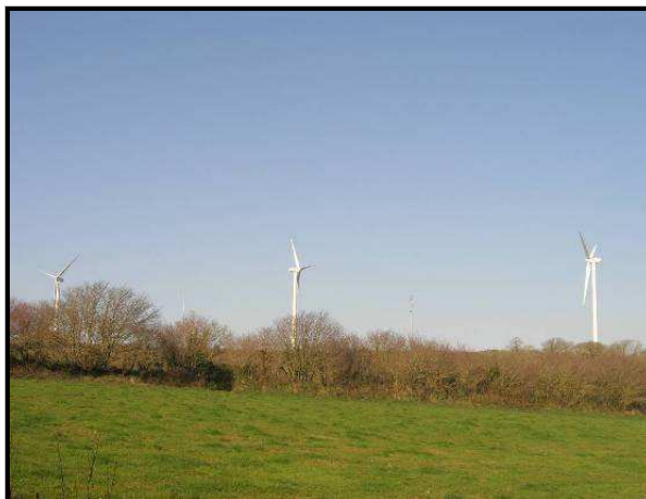
Parc éolien de Lanrivoaré (Finistère)
