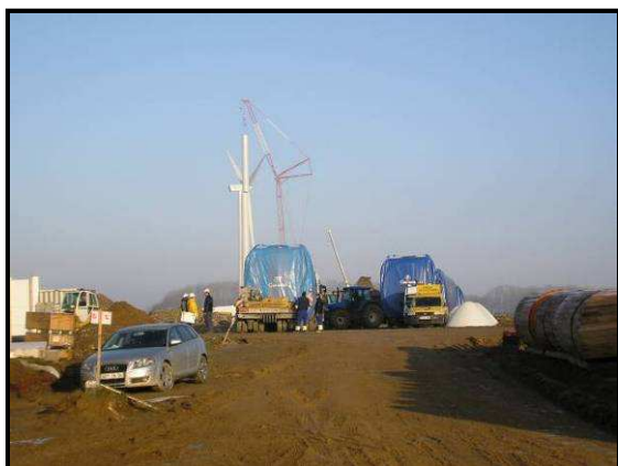
Chantier de La Picoterie : montage d'une éolienne
