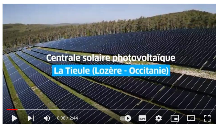
La Tieule (48) : une centrale solaire et plus encore...
