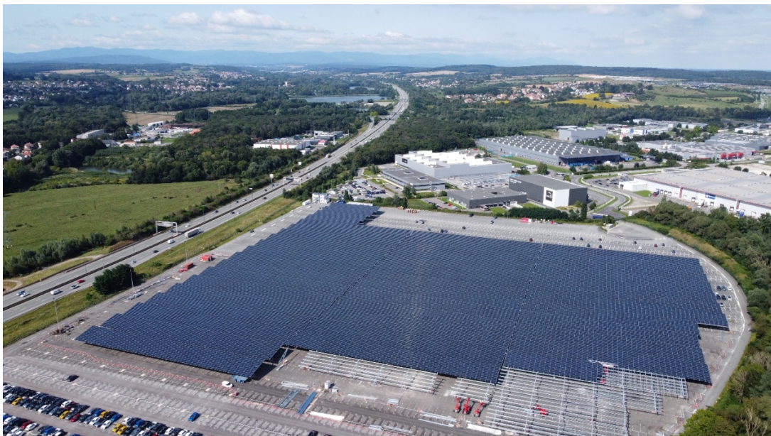
Chantier de construction de la centrale solaire en ombrières sur le site Stellantis de Sochaux
