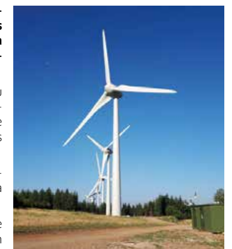
Vue partielle du parc éolien de Cabalas Centre (Hérault - 34)
