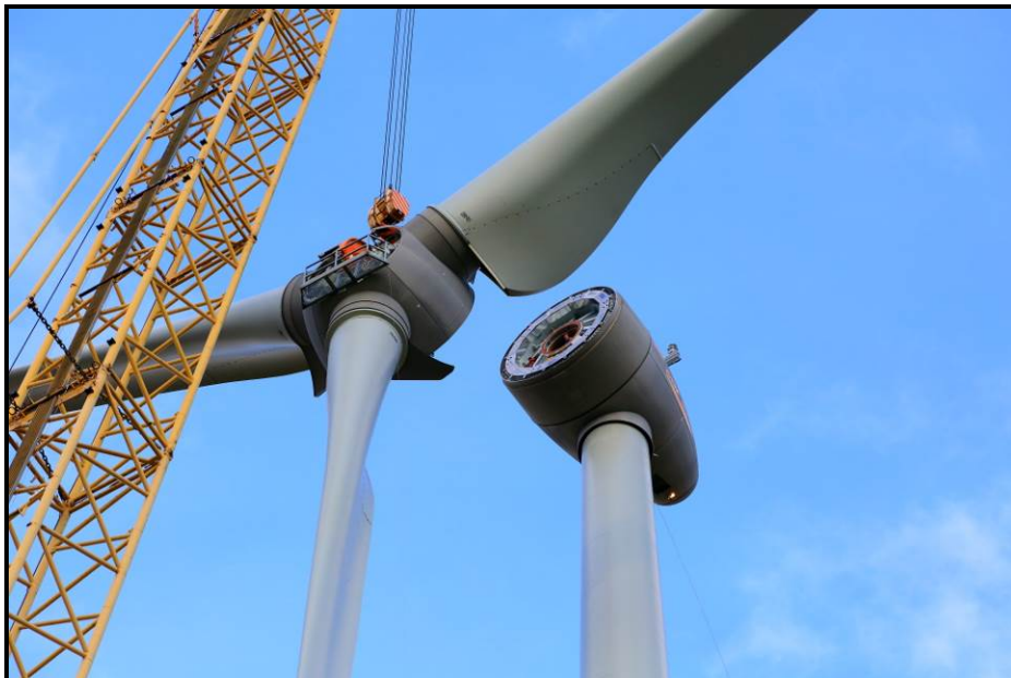
Montage éolienne parc éolien de Chemin du Bois Hubert (Oise, 60) ©David Blondin
