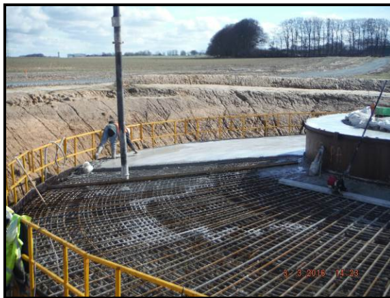
Coulage d'une fondation sur le parc éolien de Falfosse & Ramonts © D. Carpentier
