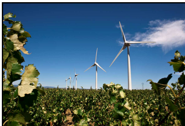
Parc éolien de Cruscades (Aude)
