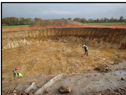
Fouille d'une fondation d'un parc éolien de La Compagnie du Vent
