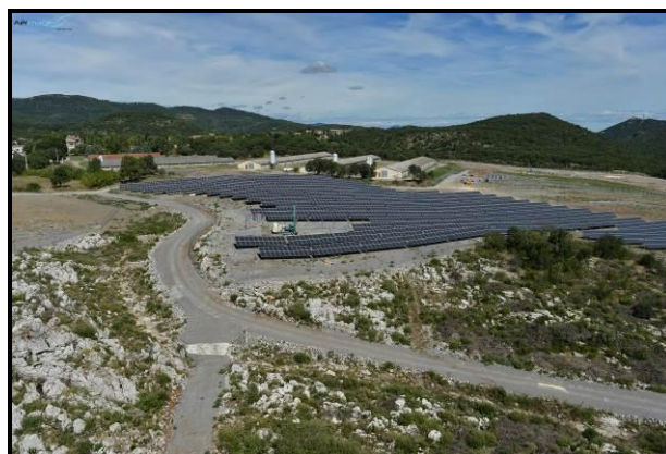
Pose des panneaux photovoltaïques © Rémi Grosset / AERIMAGE
