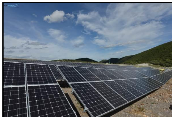
Centrale solaire photovoltaïque de La Téronde © Rémi Grosset / AERIMAGE
