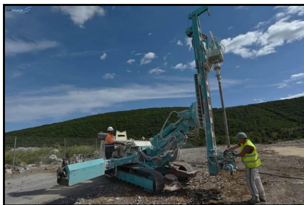
Battage des pieux accueillant les structures en acier © Rémi Grosset / AERIMAGE
