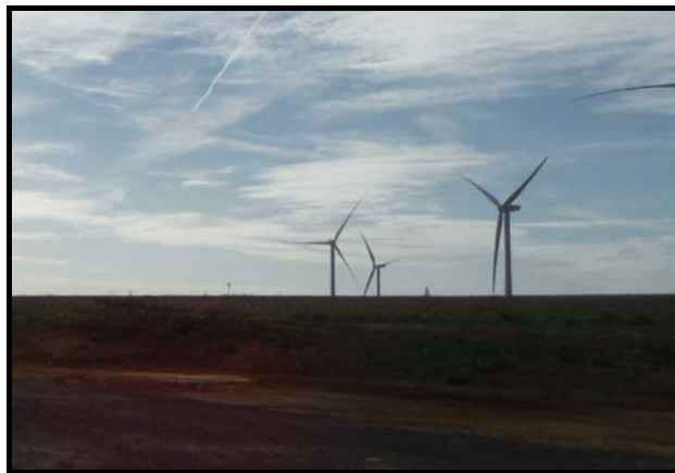
Vue partielle du parc éolien de la Voie du Moulin
