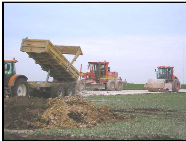
Réalisation d'une piste d'accès
