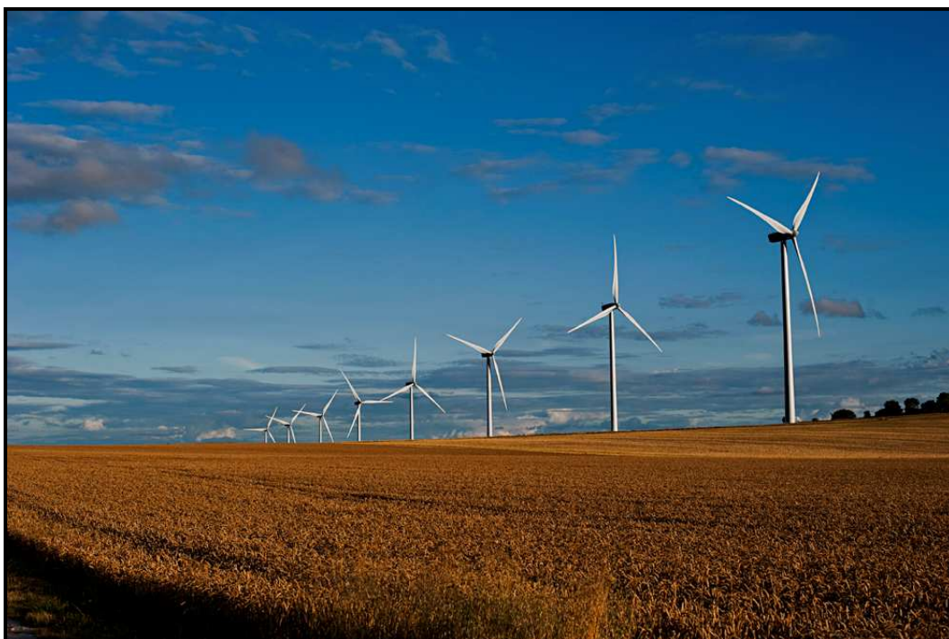
Parc éolien du Miroir (vue partielle) ©David Richard/photographe
