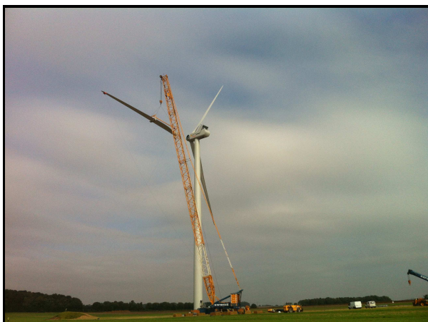
Chantier de l'Extension du Miroir : montage d'une éolienne
