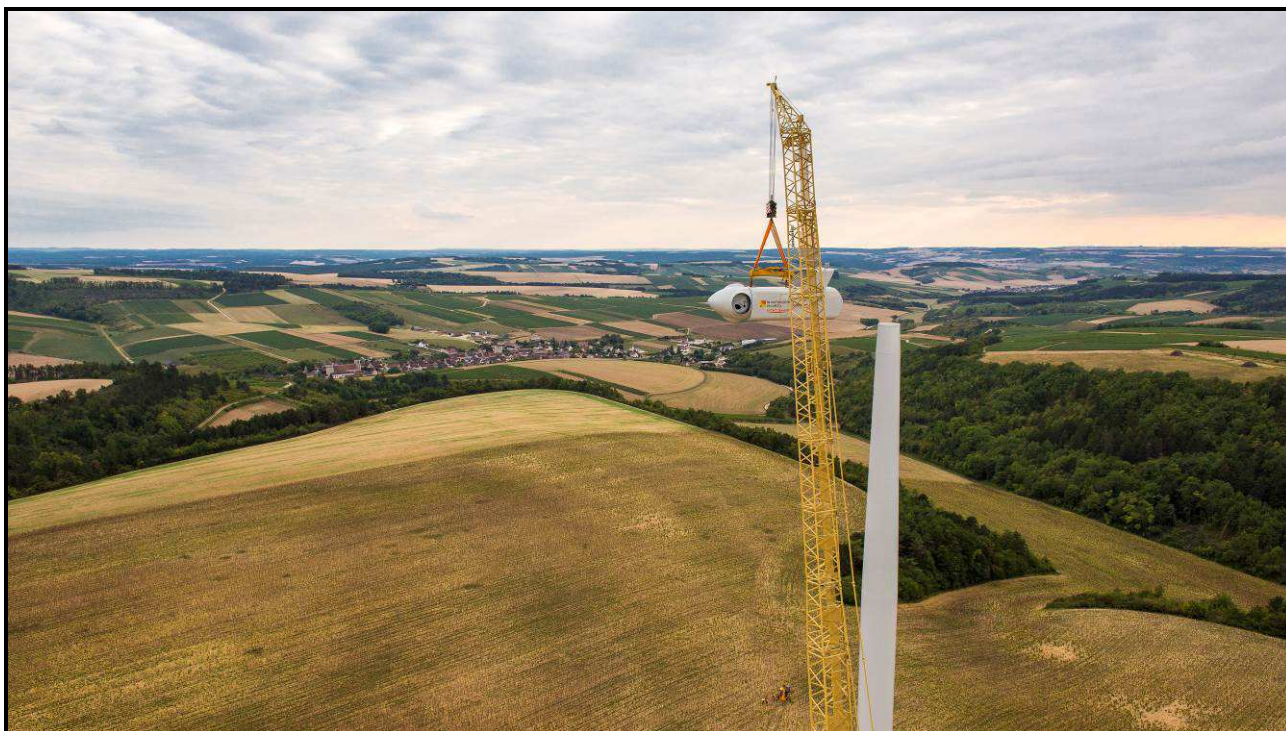
Levage d'une nacelle du parc éolien de l'Auxerrois ©ImagesInAir
