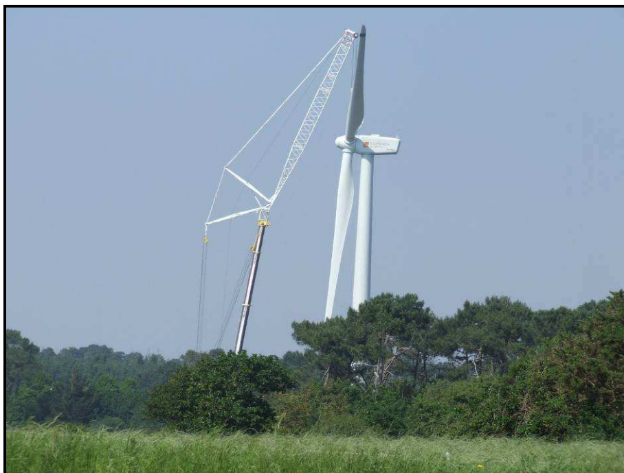
Montage d'une éolienne d'un parc de La Compagnie du Vent ©Pierrot Bosser
