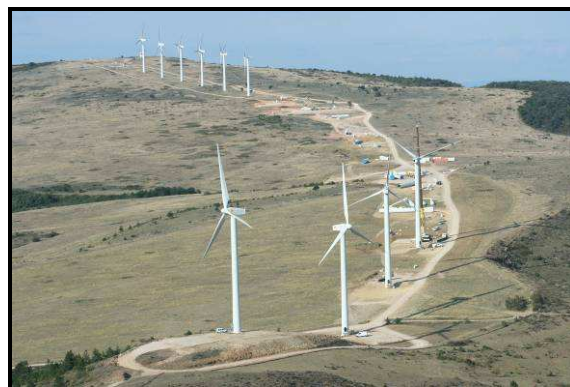
Chantier de l'extension du parc éolien de Roquetaillade © Abies
