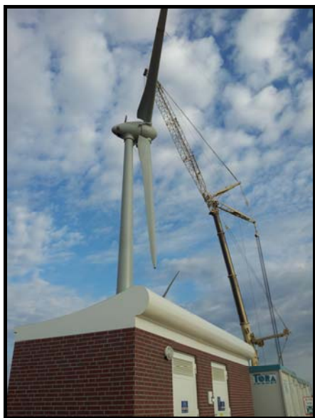
Chantier de l'Extension du Petit Terroir : montage d'une éolienne
