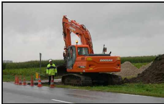
Terrassement de la piste d'accès au Petit Terroir
