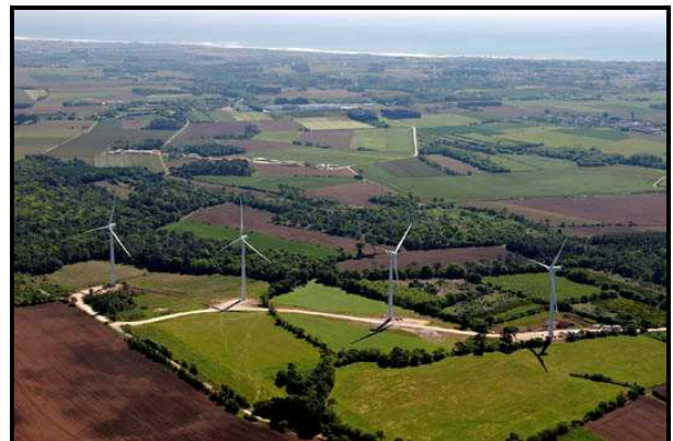
Vue partielle du parc éolien de Kérigaret (Finistère)
