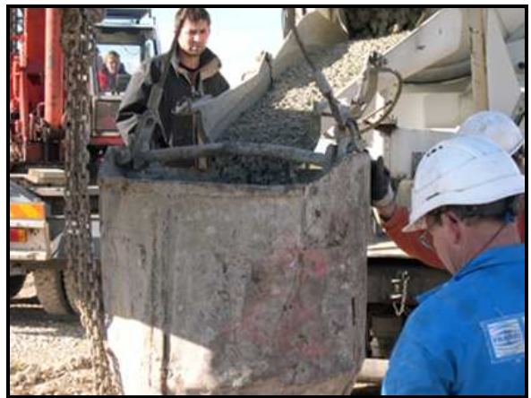
Coulage du béton pour la fabrication d'un pieu sur le chantier du Petit Terroir
