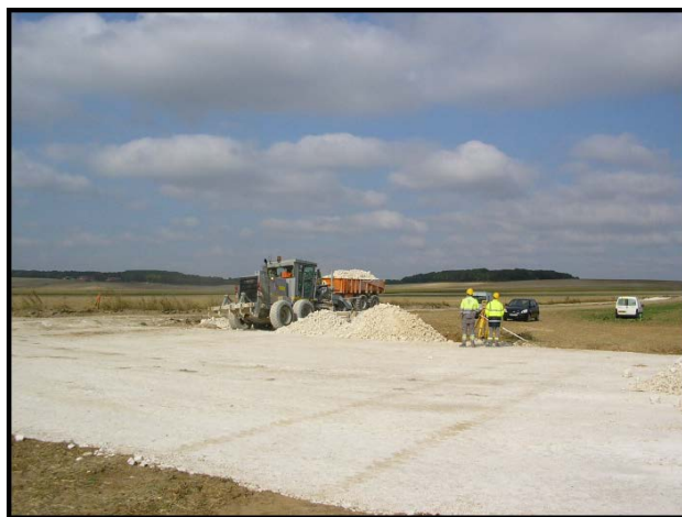
Création d'une piste d'accès - Parc éolien du Miroir
