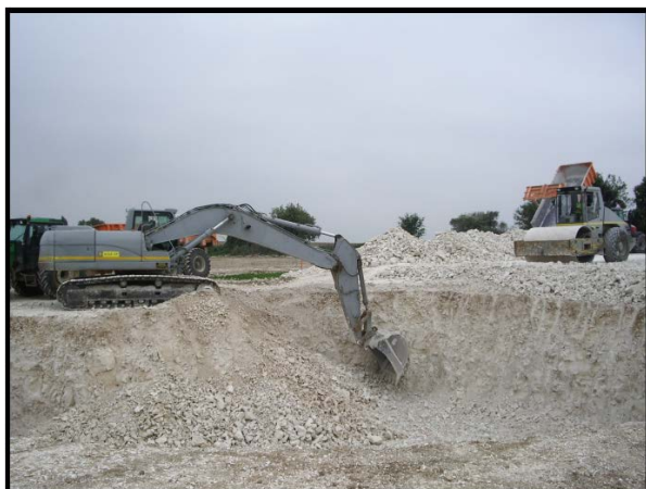
Fouille d'une fondation - Parc éolien du Miroir
