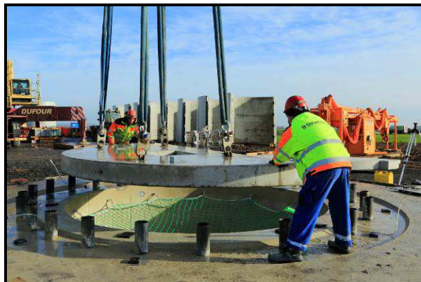
Réalisation d'une fondation du parc éolien de Chemin du Bois Hubert (Oise – 60)
