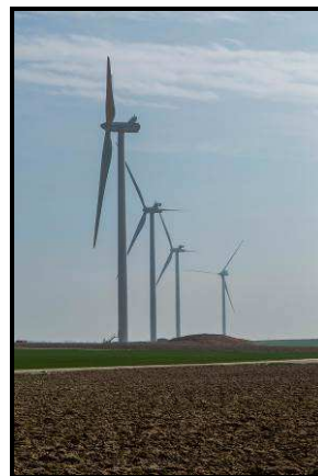
Parc éolien des Châtaigniers - © IMAGINESinAIR
