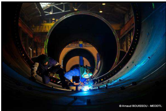
Ligne de production @Franceole
