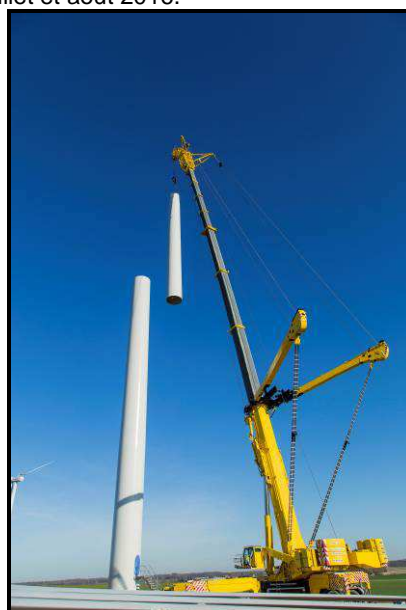
Montage d'une éolienne des Châtaigniers (Marne – 51)
