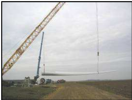
Chantier du Chemin des Haguenets : montage d'une pale
