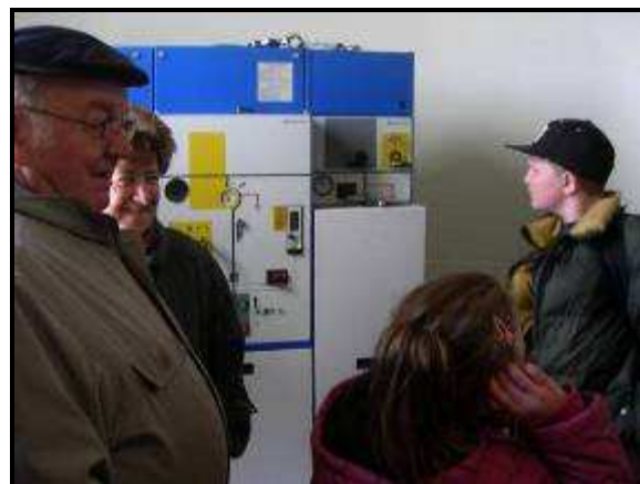
Visite de l'intérieur d'une éolienne de La Compagnie du Vent
