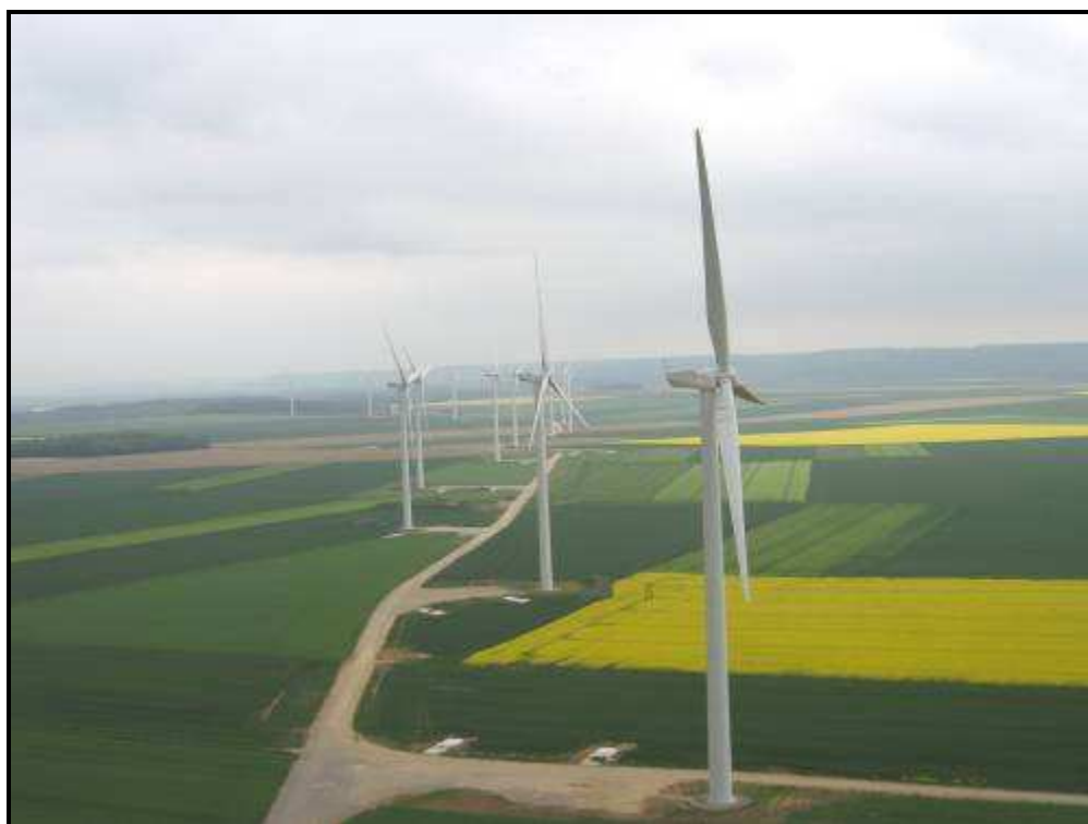
Vue aérienne du parc éolien du Chemin des Haguenets (vue partielle)
