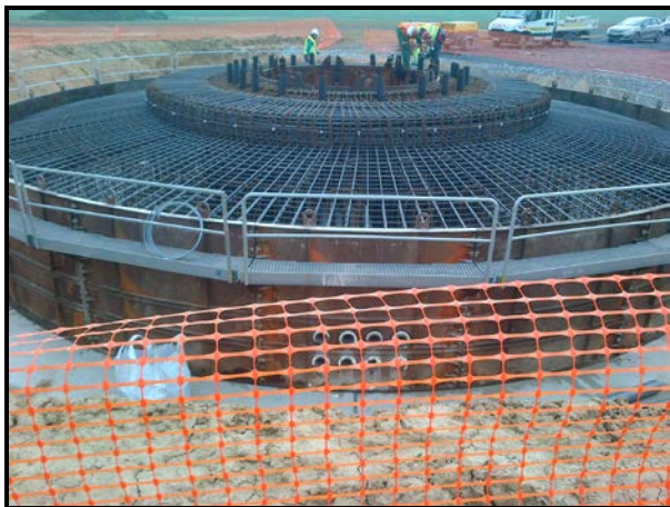
Fondation ferrailée - Chemin du Bois Hubert
