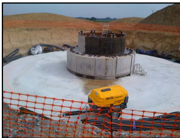
Fondation coulée - Chemin du Bois Hubert
