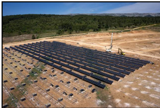
Pose des panneaux photovoltaïques © MyDrone.fr Lionel BARBE
