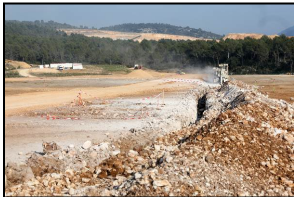
Tranchées électriques © MyDrone.fr Lionel BARBE
