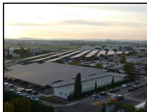
Ombrières solaires des parkings de l'Aéroport Montpellier Méditerranée
