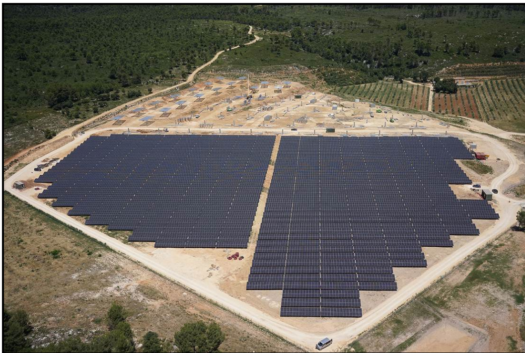
Centrale solaire photovoltaïque Le Mouruen © MyDrone.fr – Lionel BARBE
