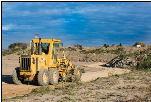
Terrassement d'un site de La Compagnie du Vent (Les Iscles- Bouches du Rhône)©My Drone.fr
