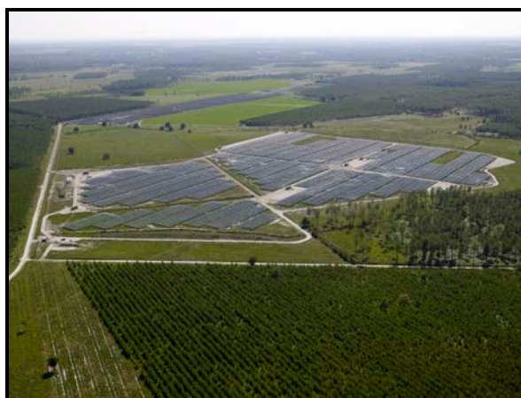
Centrale Photovoltaïque de Langelé©Air Infrarouge(Landes)
