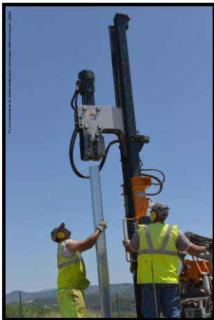
Battage des pieux accueillant les structures en acier © Rémi Grosset - AERIMAGE
