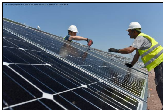
Pose des panneaux solaires -© Rémi Grosset - AERIMAGE
