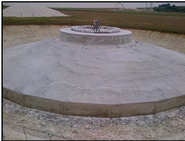
Partie supérieure d'une fondation sur laquelle sera boulonnée la tour d'une éolienne du parc éolien du Miroir
