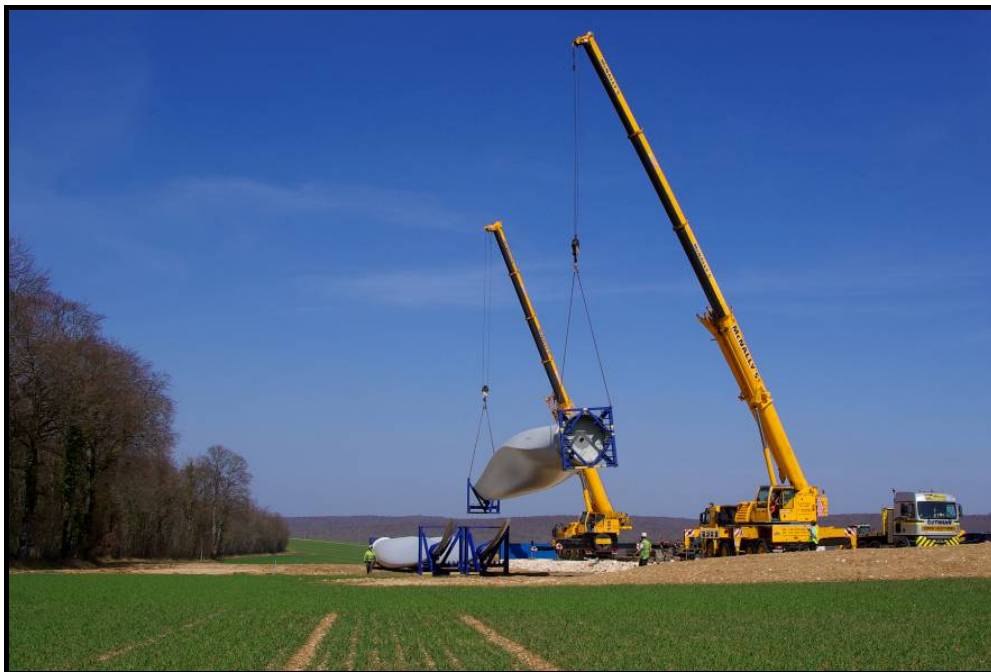
Transport de pales sur un parc de La Compagnie du Vent (parc éolien de La Bretelle et Echalot -21) ©La Compagnie du Vent/J.Bourrely
