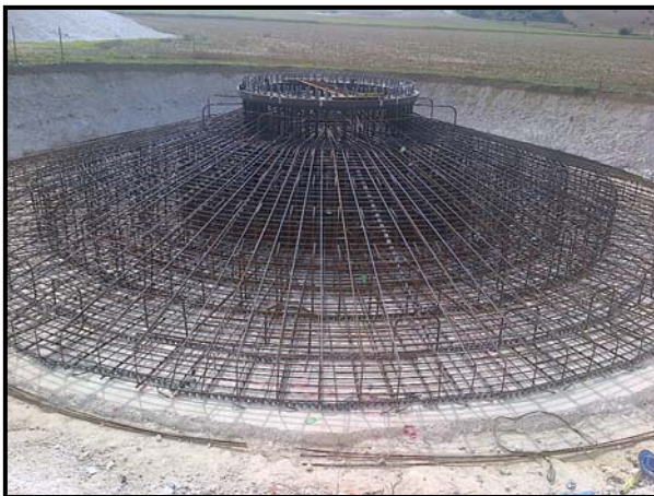
Ferrailage d'une fondation du parc du Miroir
